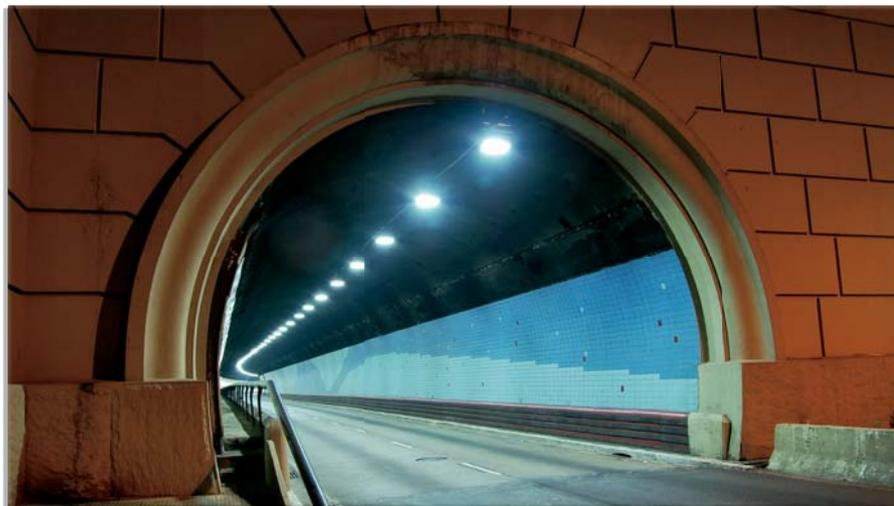
Com o projeto de iluminação, o consumo de energia anual passou de 2.026,71 MW/h para 528, 26 MW/h. Lâmpadas de indução eletromagnética melhoraram o IRC.
